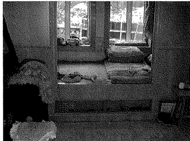
写真39 旧宅の東側の炕 両側に壁が設けられている
