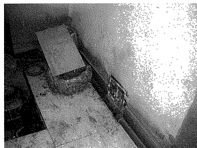
写真37 ボイラーの右横にある炕の小さな焚き口
