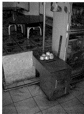
写真31 後方の炕とその焚き口
