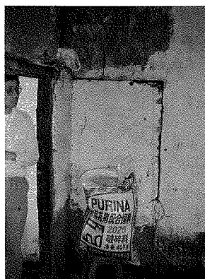
写真25 内側から見たかつての入口跡
