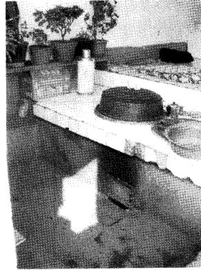
写真 22 右側の部屋の竈の焚き口 朝鮮族のように窪地になっている
