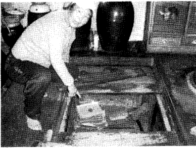
写真 35 竈の焚き口に覆われている板を取り外したところ
