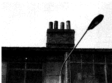
写真 59 「火炕楼」の煙突。四角い枠の中に家ごとの丸い煙突がみえる
