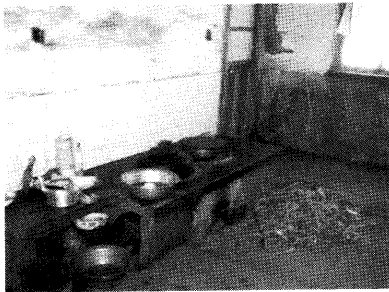
写真47 左側にある大きな炕の竈 焚き口は二つで、朝鮮族式の鍋が二つみえる
