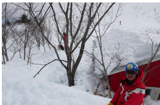
写真 5-3 東側の軒は切ってある。(3/12)
