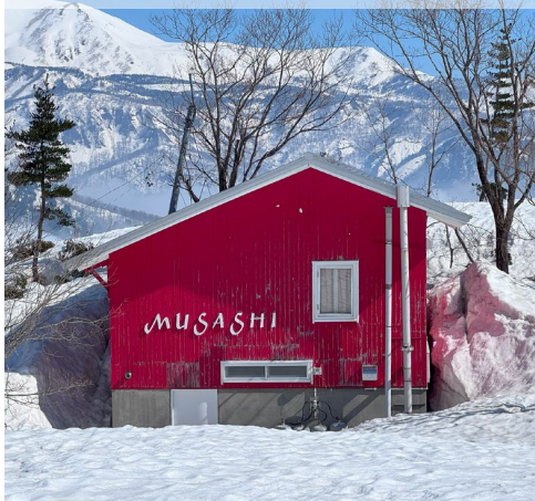
写真 9-6 2025/4/12 屋根雪は完全に落下。顕著な損傷なし。
