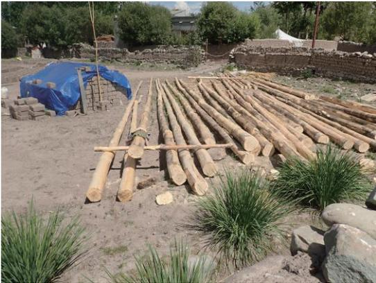
写真 26 ストック村で新築中の土地。左にレンガが積まれている。用材はポプラである。
